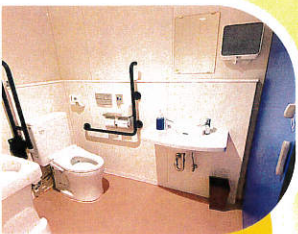
多目的 トイレ
